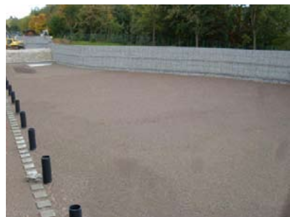
Tomma gabioner av tvinnad metalltråd eller av svetsade, stålförzinkade galler. Galvaniserat stål (alu-zink) eller av rostfritt stål.
