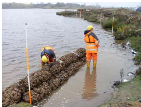
Stenrullar som är fullständigt klara för montering, fyllda med frostsäkra stenmaterial i mycket slitstarka specialnät, för släntfotsäkring inom områden med höga hydrauliska belastningar.
