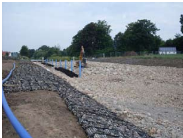
Flodmadrasser/flexibla stenmadrasser , helt fyllda innan montering för säkring av slänter och flodbottnar inom översvämningshotade områden, för kustskydd eller liknande användning.
